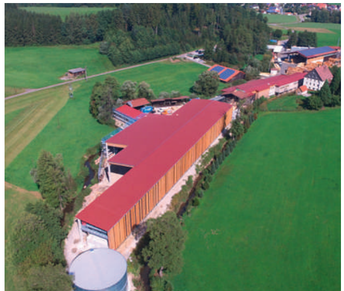
Wiederaufbau nach Millionenschaden: die neue Paketier- und Sortieranlage des Sägewerks Kolb
